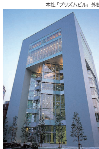
本社「プリズムビル」外観
